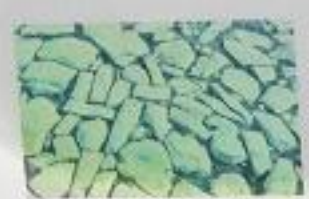
石材の長辺を埋め込み
