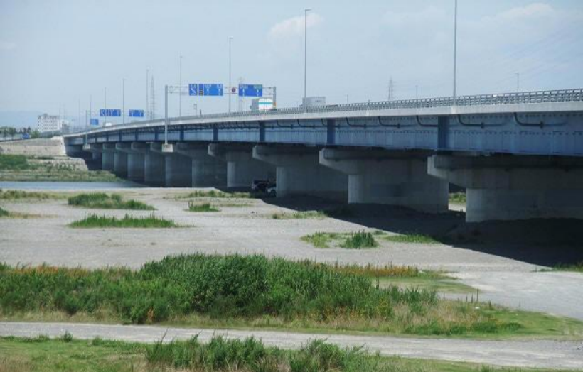
新天竜川橋(広い歩道あり)
